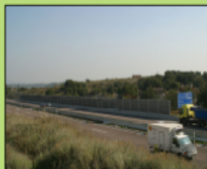
4 PANTALLA HORIZONTAL FONDOABSORBENTE P.K. 495,500
