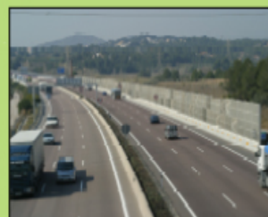
8 PANTALLA HORIZONTAL FONDOABSORBENTE P.K. 501,940
