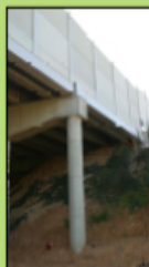
7 PANTALLA EN ESTRUCTURA SOBRE BARRICADA P.K. 498,000
