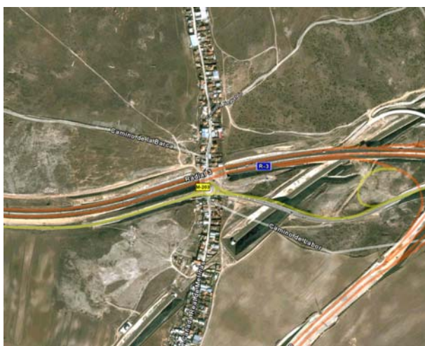
Entorno de la Cañada Real Galiana (PK 7+100)
