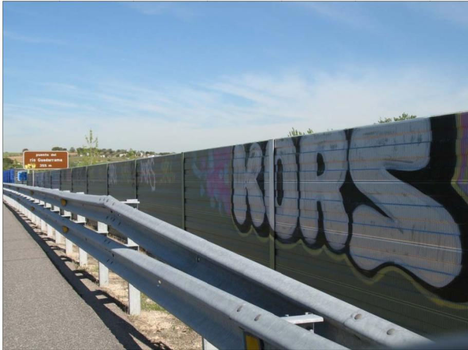
Imagen de pantallas acústicas cercanas a viaducto sobre el río Guadarrama (margen derecho)
