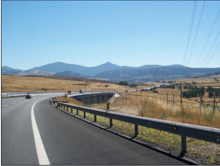
Viaducto de Arenales
