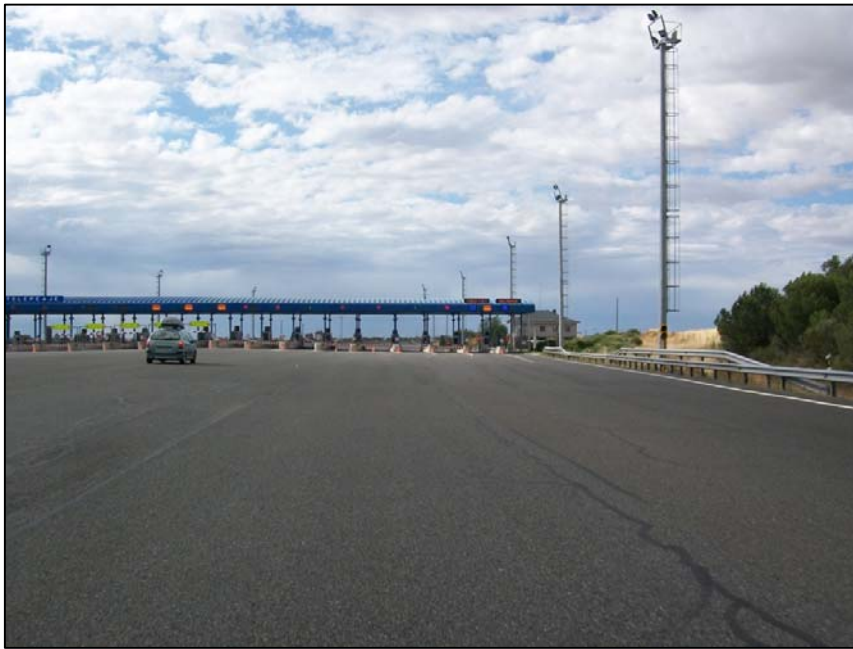
Peaje sentido A Coruña
