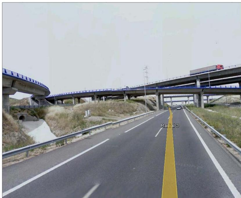
En este tramo nos encontramos con un viaducto de aproximadamente 1000 m de longitud desde la Carretera M-206 hasta la Carretera M-203 y 10 metros de altura máxima. Al final del tramo con el enlace a la Carretera M-203 nos encontramos Pantallas Acústicas de Metacrilato de 2 metros de altura.
